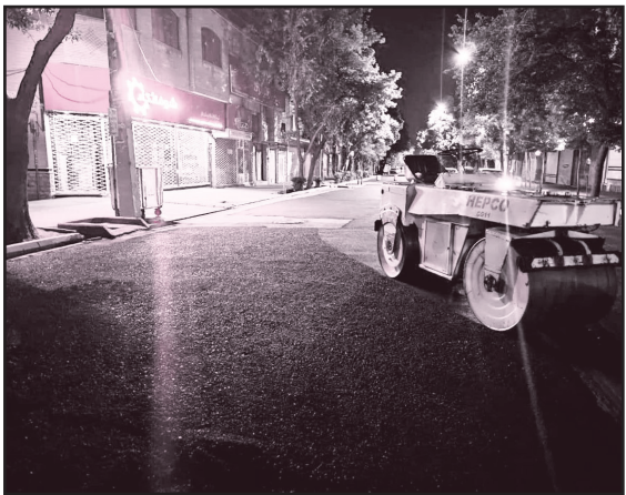
طرح نو؛ گروه شهری شهردار منطقه ۸ تبریز، از اجرای ۳۸۰ تن آسفالت ریزی در خیابان دانشسرا خبر داد.
